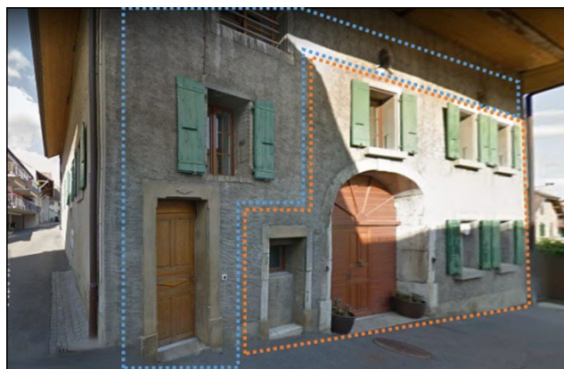
Façade principale sud-ouest donnant sur la rue Saint-Laurent
