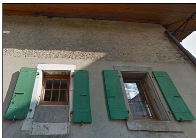
Façade nord-ouest donnant sur la rue du chaffard
