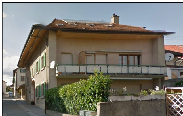
Nouvelle façade sud-ouest ouvrant sur le jardin
