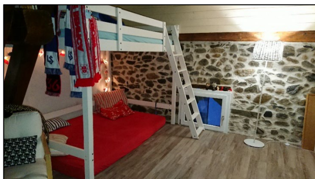
Chambre aménagée dans les combles, avec mur extérieur en moellons apparents
